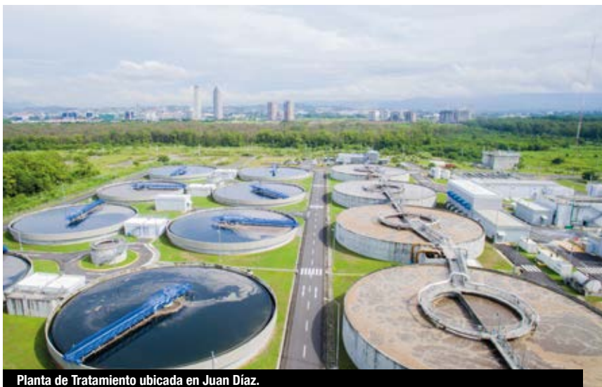
Planta de Tratamiento ubicada en Juan Díaz.
