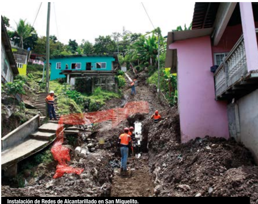
Instalación de Redes de Alcantarillado en San Miguelito.
